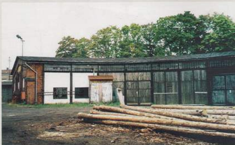
Dawna parowozownia i wieża ciśnieni.
