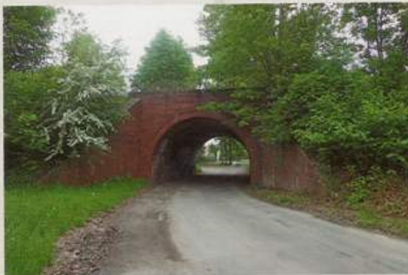
Bezkolizyjne przejścia ulic miejskich pod liniami wybiegającymi ze stacji: nad ulicą Kolejową i nad drogą gruntową, wzniesione prawdopodobnie jednocześnie z bieżącymi górą ocinkami linii. Fot. P. Koczyk (24.05.2013)
